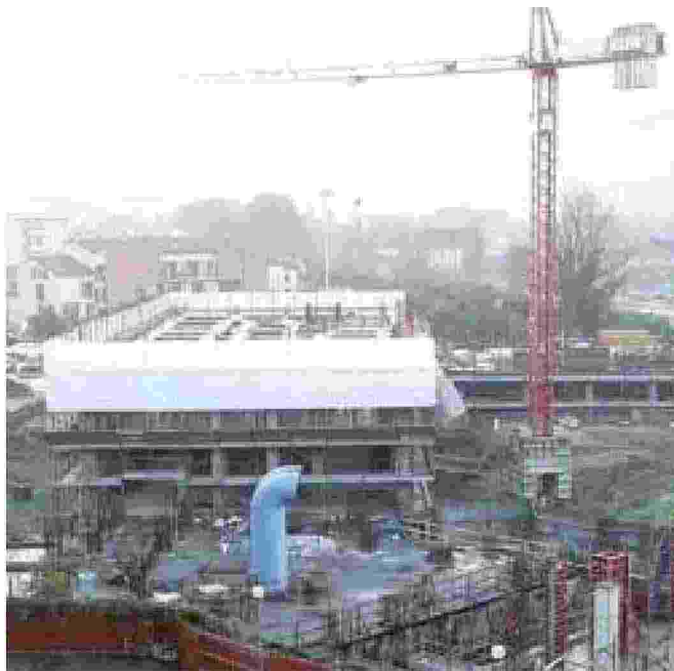
I lavori in corso per la realizzazione dell'Rsa hospice di Sarzana
